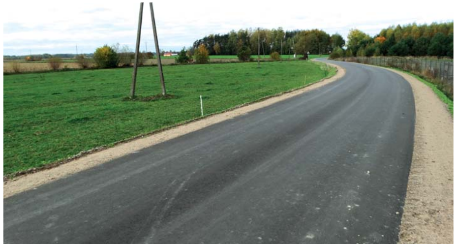
Droga gminna nr 311017W w miejscowości Charzyny po przebudowie
