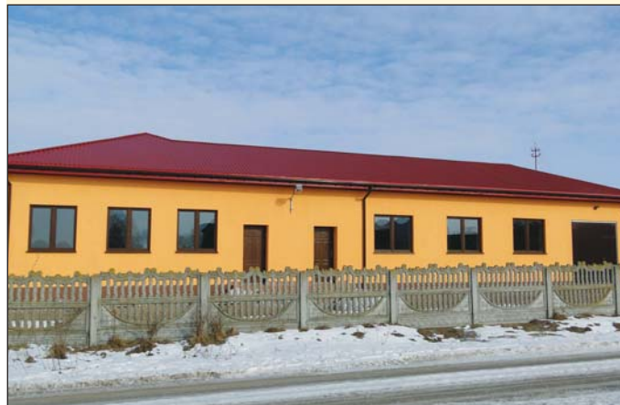
Tak wygląda remiza OSP w Jeżewie Wesel po remoncie
