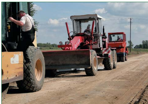
Maszyny firmy Wapnopol, wykonawcy inwestycji, ubiły trakt i położyły na niego warstwę utwardzającej suchej mieszanki z cementem, by w następnych dniach położyć asfalt
