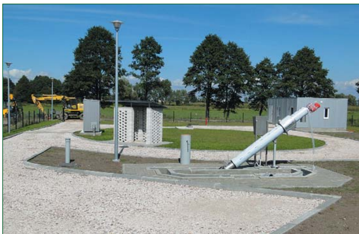
Punkt przyjmowania ścieków i oddzielania elementów stałych
