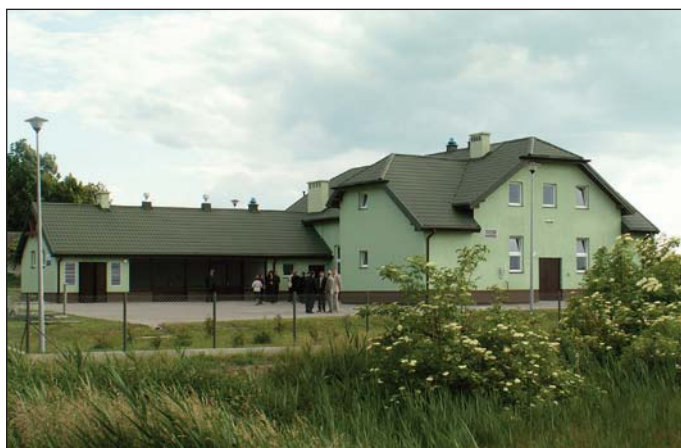
Oczyszczalnia ścieków w Gralewie
