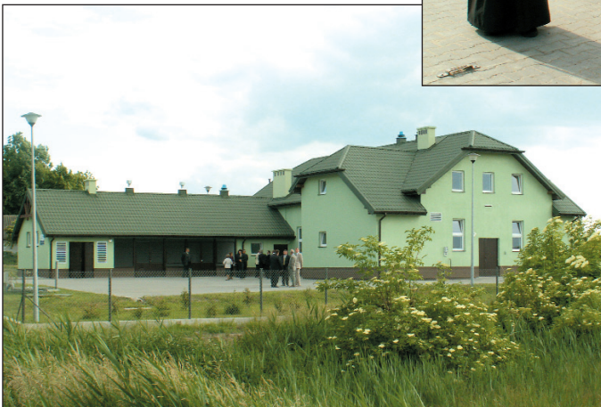
Wszystkie urządzenia gralewskiej oczyszczalni są ukryte w ziemi lub w budynku
