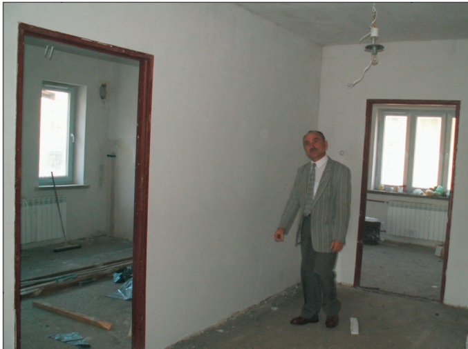
Wszystko wskazuje na to, że modernizacja budynku wewnątrz zostanie zakończona jeszcze w tym roku – zapewnia wójt Ryszard Giszczak
